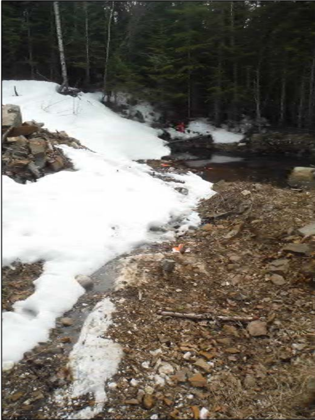
Photo 6 : Zone de la tranchée 3
