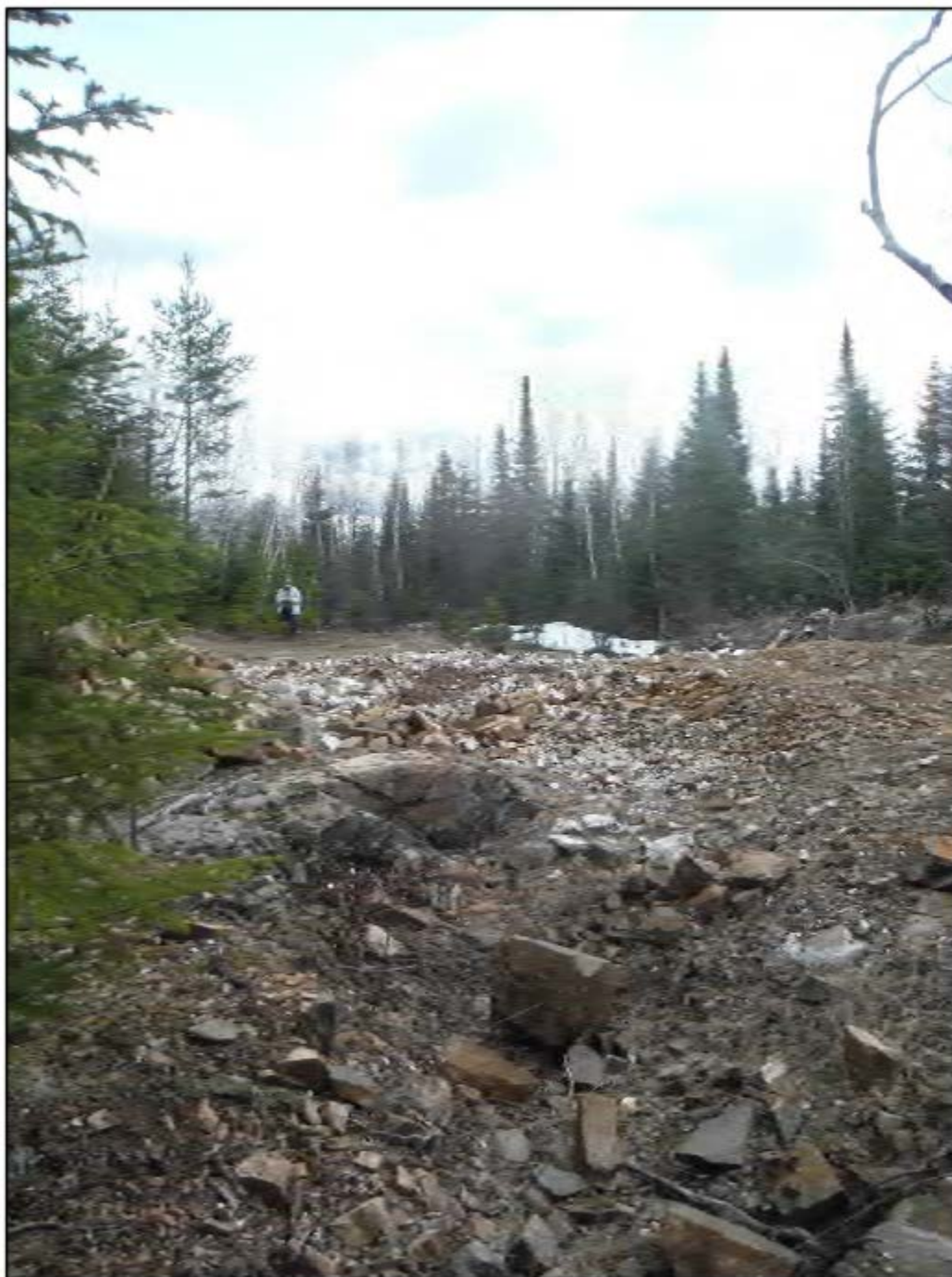
Photo 3 : Zone de la tranchée 1
