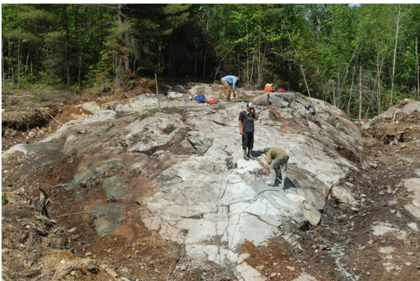
Photo 1 : Photo montrant le site du projet après enlèvement des morts-terrains.
