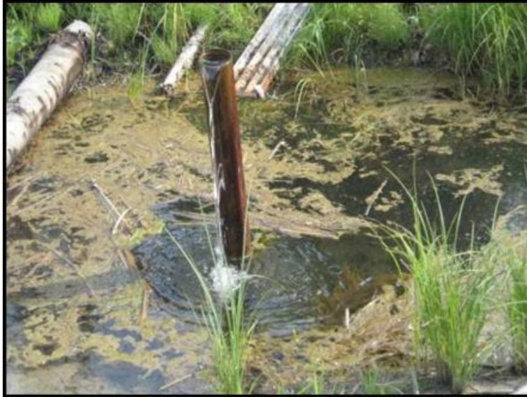
Photo 11 : Trou de forage avec tubage d'où l'eau s'écoule, avant le scellement.
