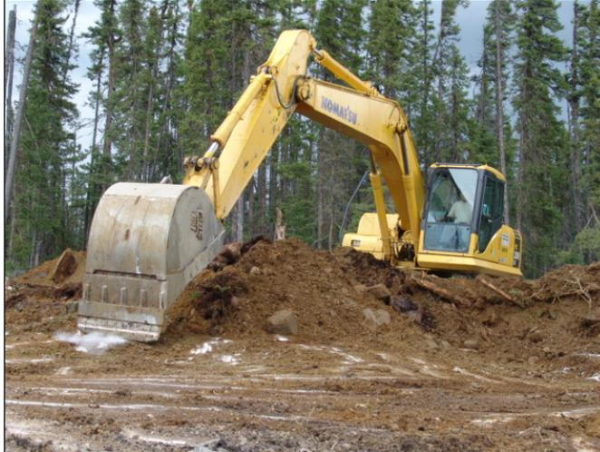
**Photo 3 : Une rétrocaveuse sert à décaper les morts-terrains.**
