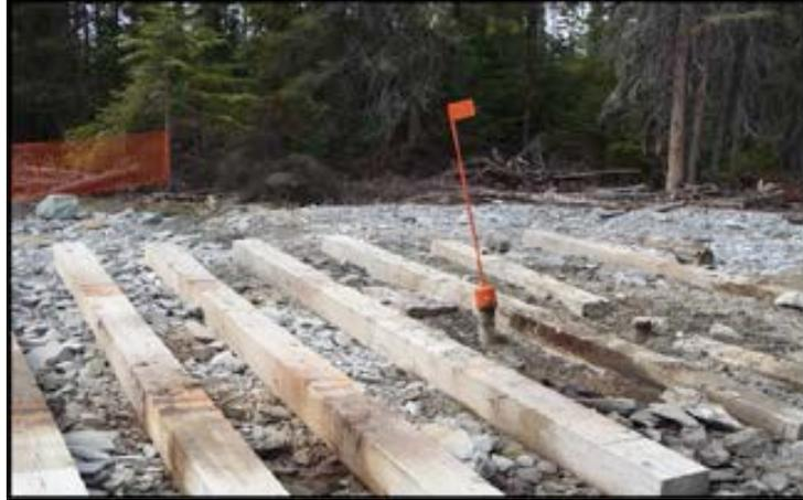
**Photo 10 : Un tubage de forage, marqué d'un capuchon et d'un fanion.**
