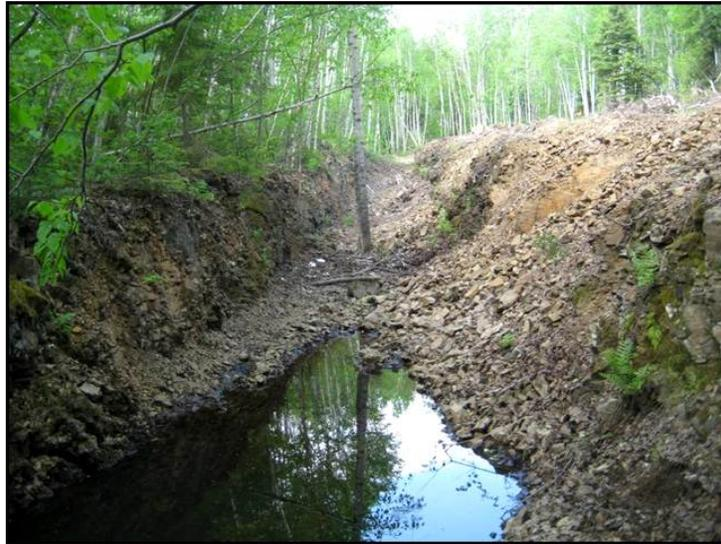
**Photo 7 : Exemple d'une tranchée linéaire de plus de 3 mètres cubes dans le substrat rocheux.**
