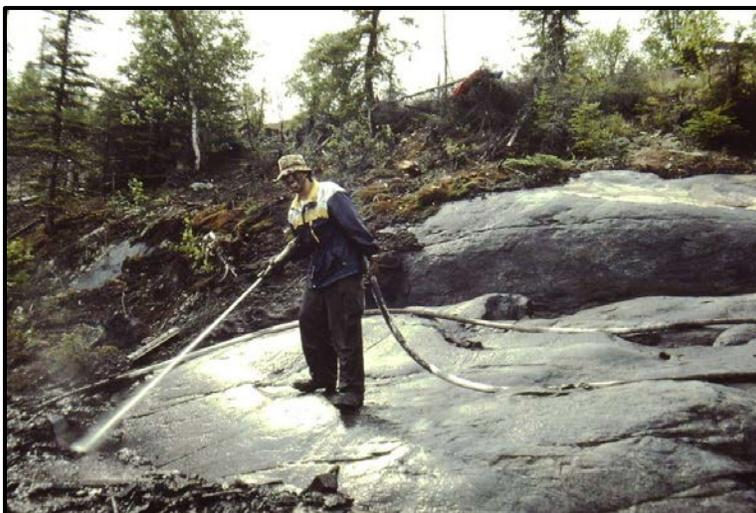
**Photo 5 : Diverses techniques, dont le nettoyage à jet puissant, servent au décapage et au nettoyage des morts-terrains.**
