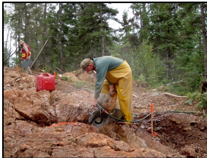
Photo 7 : Échantillonnage en rainure dans une petite tranchée de moins de 3 mètres cubes qui a également été décapée.
